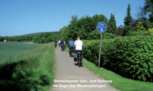
Abschnitt mit wassergebundener Decke auf dem Weserradweg
