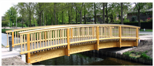
Fuß- und Radwegebrücke über die Hamelmündung
