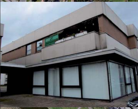
Gebäudebestand – Baulicher Zustand
